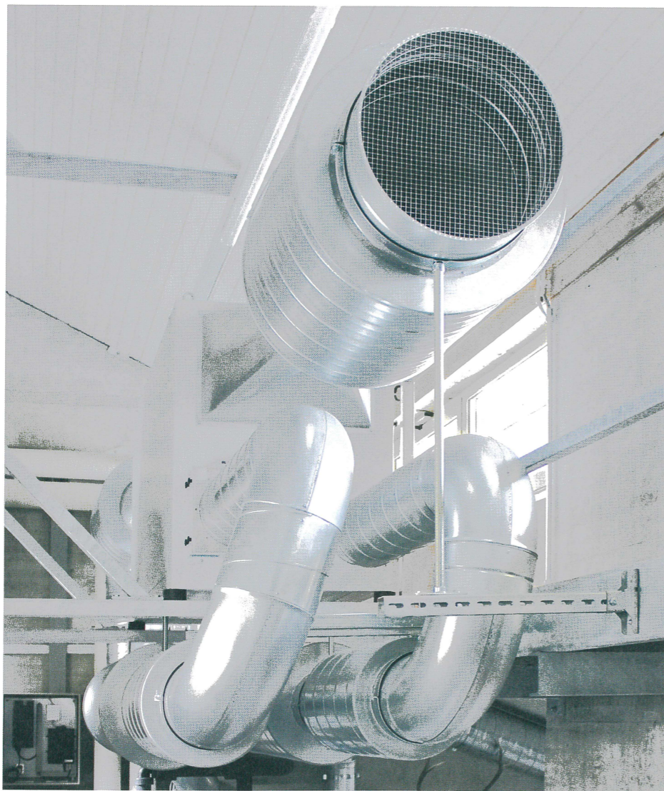
Direkt unter der Decke: Für das Entfeuchtungsgerät konstruierte Krüger eine spezielle Konsole.
